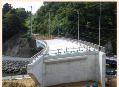
①国道398号新相川橋災害復旧工事 ②石巻市北上町十三浜地内 ③通行止めの新相川橋を施工中 ④82%
