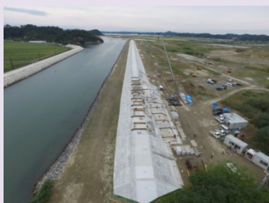
①東名地先海岸災害復旧工事 ②東松島市東名地内 ③被覆ブロック据付中 ④91%
