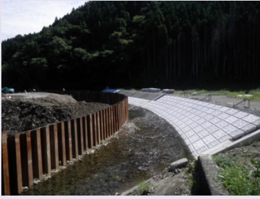
①相川沢川災害復旧工事 ②石巻市北上町十三浜字相川地内 ③護岸工を施工中 ④40%。
