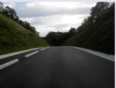
①出島道路改良工事 ②女川町出島地内 ③アスファルト舗装工を施工中 ④98%
