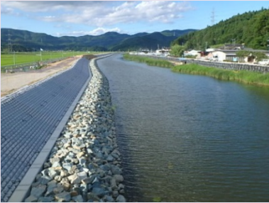
①真野川外4河川災害復旧工事 ②石巻市大瓜地内外 ③日向地区で築堤・護岸工を施工中 ④50%
