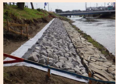
①北北上運河災害復旧工事 ②石巻市蛇田地内外 ③北北上運河左岸で縮井石積み工を施工中 ④29%
