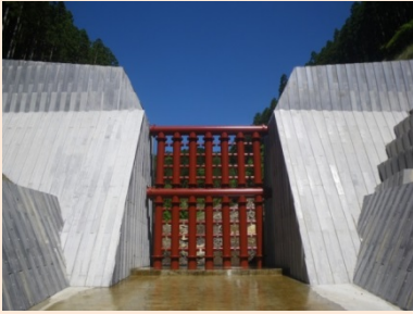
①鯉取沢砂防堰堤工事 ②石巻市北上町長尾字鯉取地内 ③平成28年6月完成
