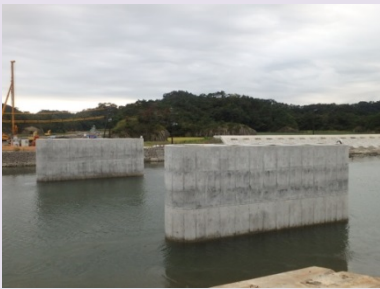
①宮戸道路改良工事 ②東松島市宮戸地内 ③松ヶ島橋で下部工を施工中 ④20%
