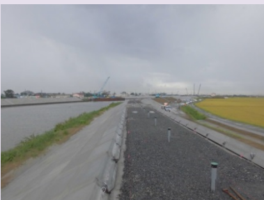
①定川災害復旧工事 ②東松島市大曲地内外 定川右岸で天端工を施工中 ④66%
