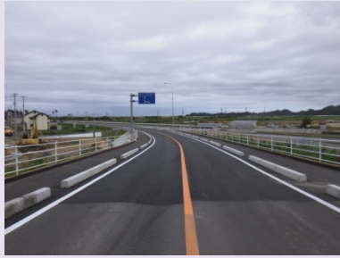
①野蒜道路災害復旧工事 ②東松島市野蒜地内 ③野蒜地区で排水工を施工中 ④37%
