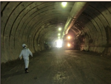
①国道398号相川復興道路事業 ②石巻市北上町十三浜 ③橋梁下部、トンネル等を施工中 ④19%
