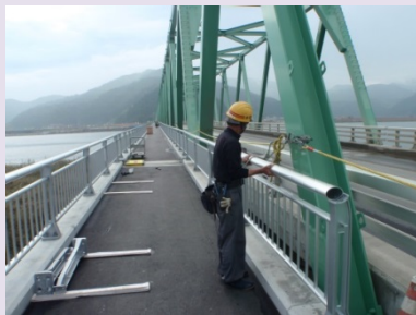
①新北上大橋災害復旧工事 ②石巻市北上町橋浦地内 ③平成28年6月に車道部開通。歩道部分を施工中 ④77%
