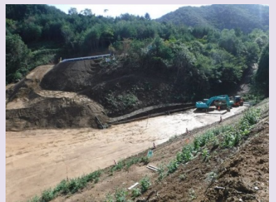
①小乗浜復興道路工事 ②女川町小乗浜地内 ③路体盛土と橋梁下部工を施工中 ④7%
