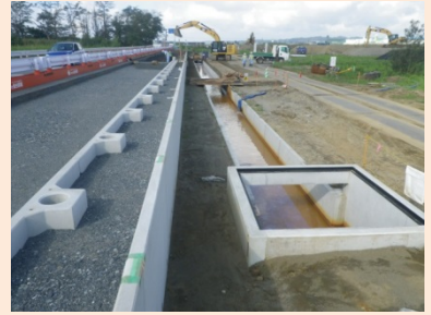
①大曲道路災害復旧工事 ②東松島市大曲地内 ③大曲地区で排水工を施工中 ④23%
