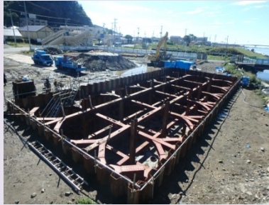
①国道398号内海橋災害復旧工事 ②石巻市中央地内 ③旧北上川左岸においてA2橋台を施工中 ④37%
