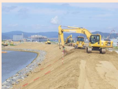
①南北上運河災害復旧工事 ②東松島市大曲地内外 ③右岸側で盛土工を施工中 ④29%
