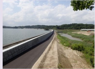
①大東地先海岸堤防工事 ②東松島市大塚地先 ③平成28年7月完成
