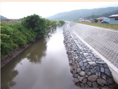
①追波川外4河川災害復旧工事 ②石巻市三輪田地内外 ③石巻市三輪田～福地地区で護岸工を施工中 ④65%
