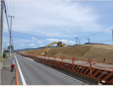
①門脇流留線道路改築工事 ②石巻市門脇～魚町 ③魚町工区において本線部盛土工中 ④14%
