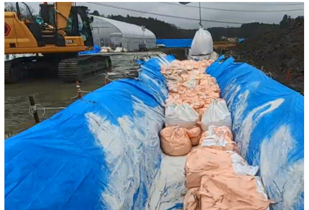
写真4 埋却作業の様子
