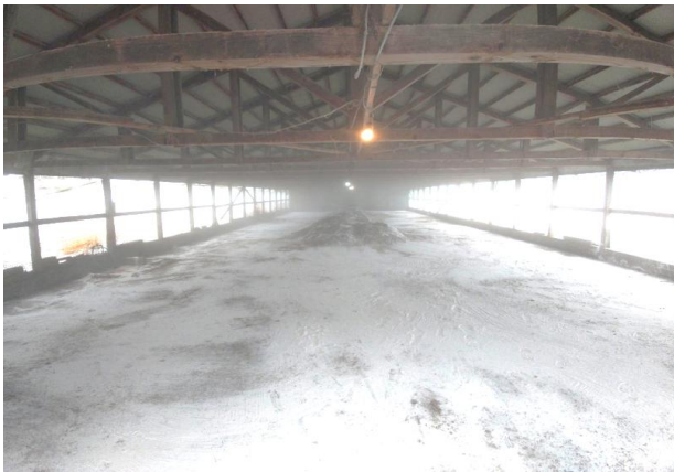
写真3 消毒後の家きん舎内の様子
