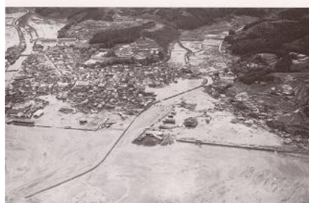
昭和35年5月24日 チリ地震津波 志津川町の浸水状況
