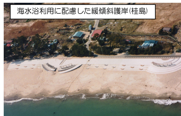
写真-4.1 海浜利用に配慮した整備例
