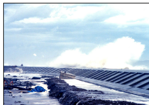
堤防に打ち寄せる高波浪（東松島市）
