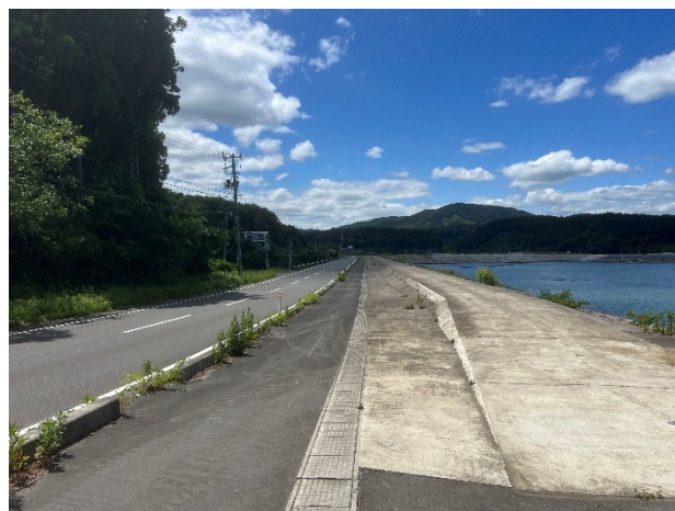
完成写真 (戸倉地区海岸)
