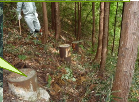
地すべり対策（土砂抑止） → 鋼管杭地中打設
