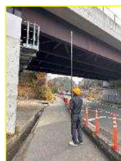
試作した治具を設置し橋梁を撮影
