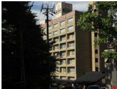
耐震改修完了（鳴子ホテル）
