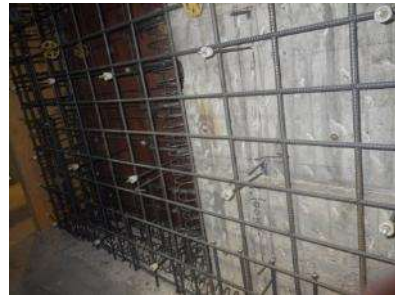
改修工事の状況
