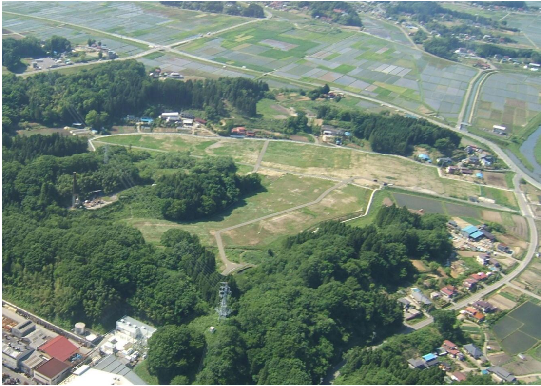
図 26 雨水浸透防止対策施工後の全景
