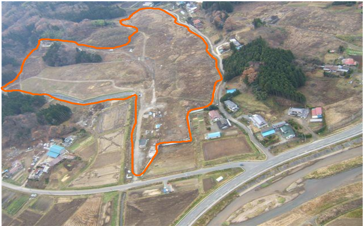
図3 処分場全景 (平成18年12月7日撮影)
