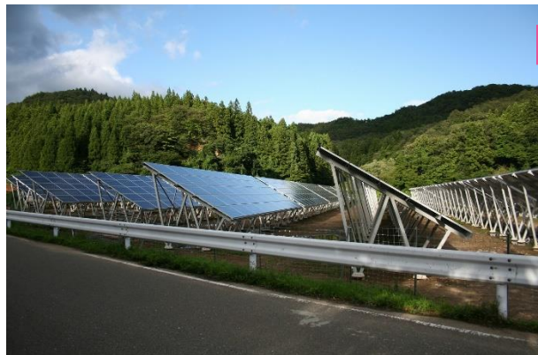
花山第一太陽光発電所 (出力: 635kw)
