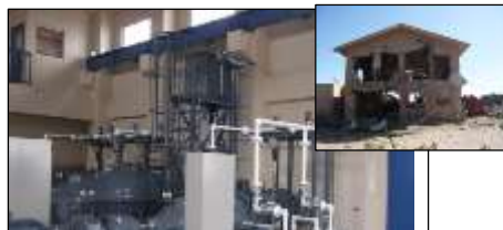
復旧した花笠第2排水機場(山元町)
