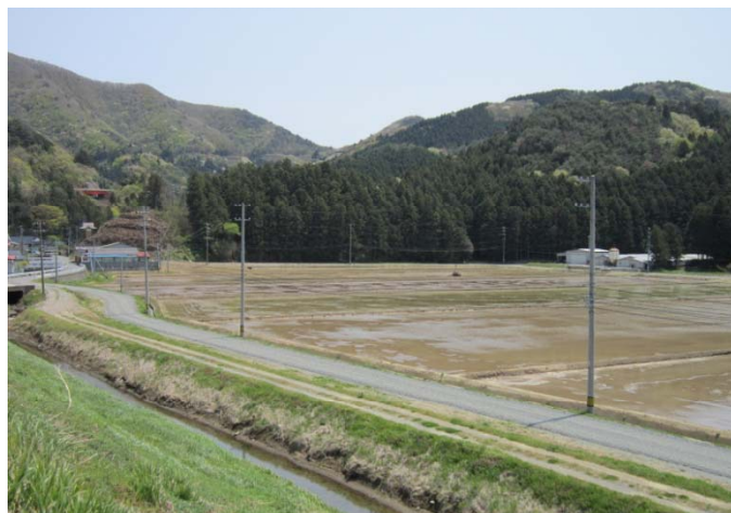
H25.5.9 復旧工事後
