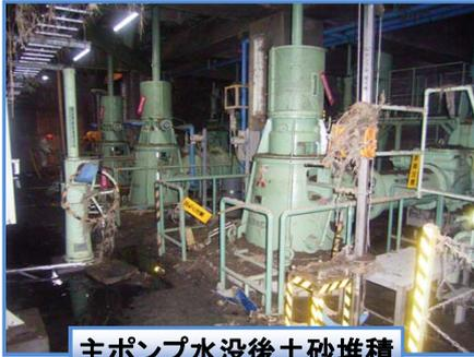
主ポンプ水没後土砂堆積
