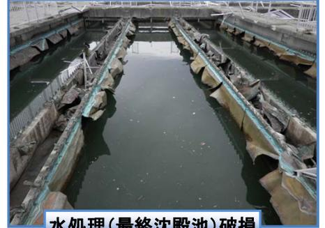
水処理(最終沈殿池)破損
