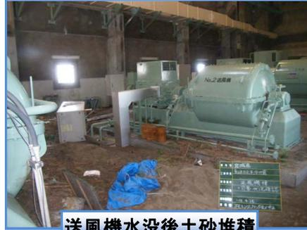
送風機水没後土砂堆積
