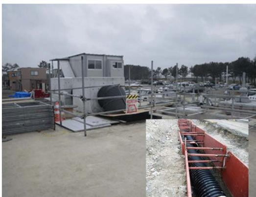
仮導水管による5系2/2水路への送水
