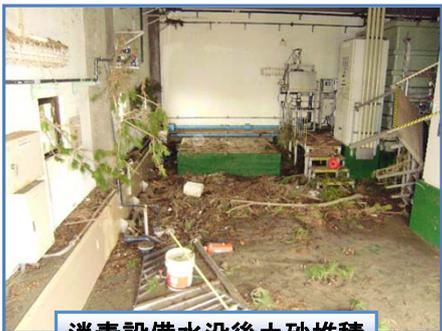
消毒設備水没後土砂堆積
