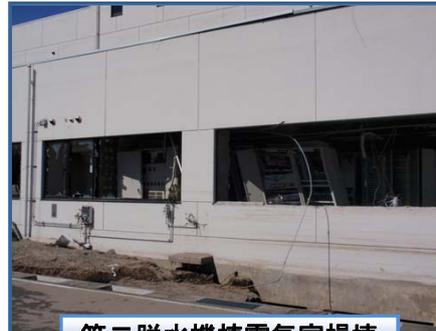
第二脱水機棟電気室損壊
