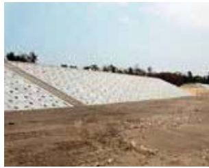
写真：復旧した海岸堤防(七ヶ浜町)
