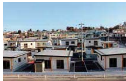
写真: 災害公営住宅(塩竈市)
