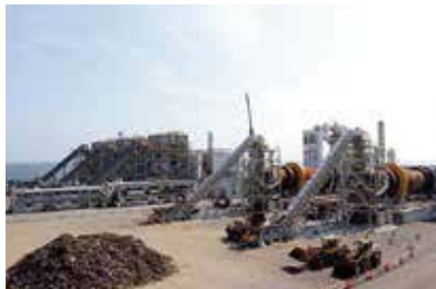
写真：災害廃棄物二次仮置き場（石巻市）
