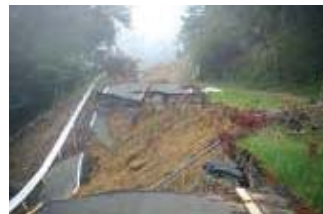
▲被災直後 写真：被災した道路の復旧状況(女川町)
