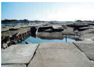
写真:被災した関上漁港(名取市)
