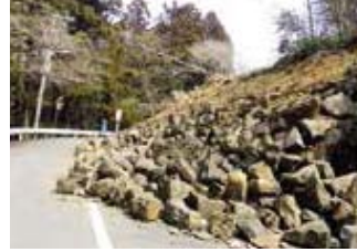
写真：被災した仙台城跡の石垣(仙台市)
