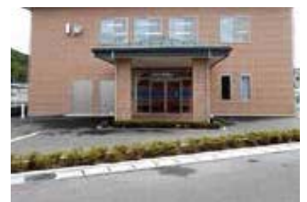
写真：復旧した高齢者福祉施設(石巻市)
