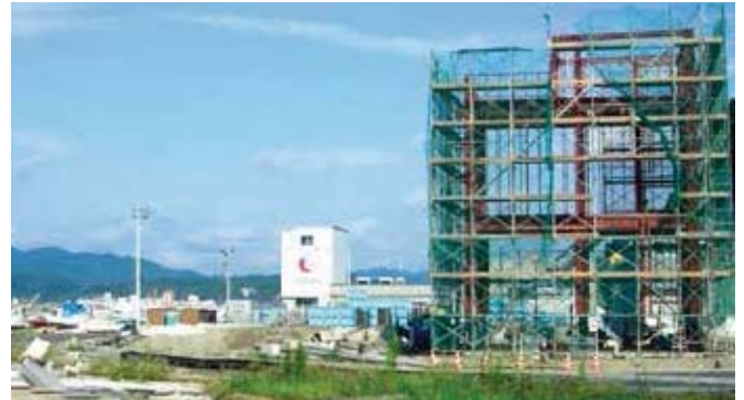
写真:復旧が進む水産加工工場(南三陸町)
