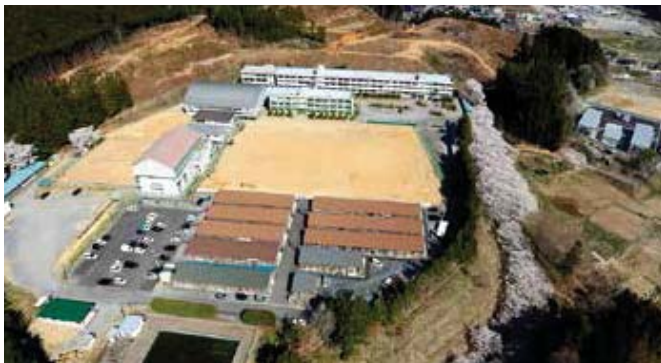
写真：校庭に応急仮設住宅(プレハブ住宅)が建つ志津川高校(南三陸町)
