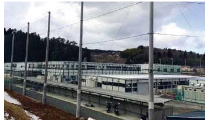
写真：気仙沼向洋高校仮設校舎(気仙沼市)
