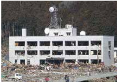
写真:津波被害を受けた県の合同庁舎(南三陸町)
