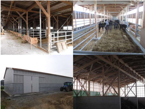
図 2：施設整備した畜舎（上）と堆肥舎（下）
