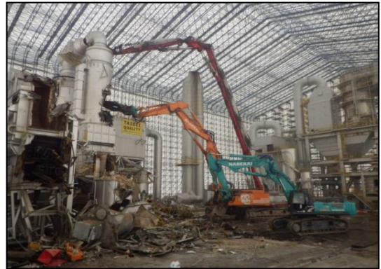
写真11-3 全覆いテントの中での解体作業 (気仙沼処理区小泉地区)
