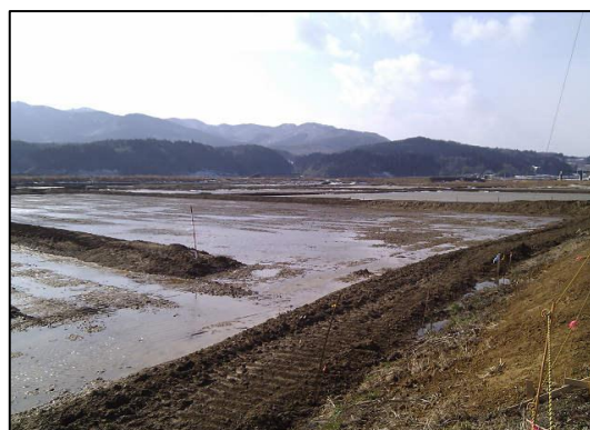
写真11-5 気仙沼処理区小泉地区の農地復旧工事
