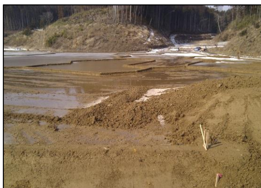
写真11-4 南三陸処理区の農地復旧工事
