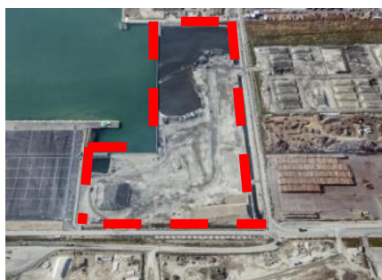
石巻港湾埋立事業 焼却灰造粒固化物，再生土砂等 (石巻市)
