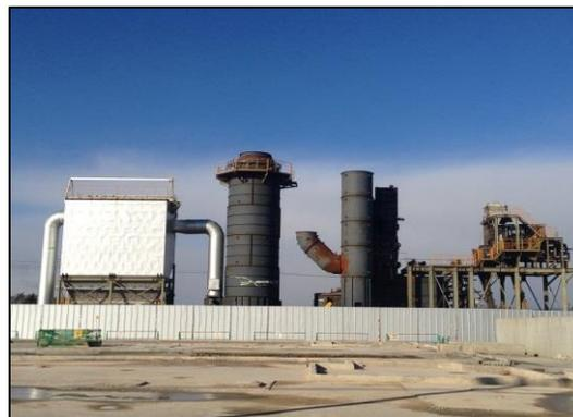
写真11-2 岩沼処理区焼却炉の部分覆い
