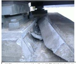
写真-3 小田ダム取水塔管理橋被災状況
