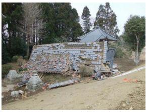
被災状況(左:鉄筋コンクリート造建築物2階部分の圧壊 右:木造建築物の倒壊)
