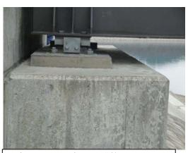
写真-4 小田ダム取水塔管理橋復旧状況
