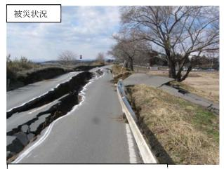
一級河川迫川 栗原市若柳大林地内 堤防被災状況(陥没·沈下)
