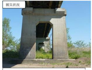
(主) 古川松山線志田橋 大崎市古川下中目~松山下伊 場野地内 P 6 橋脚破損状況 (コンクリート巻立補強)
