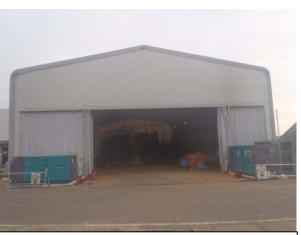
写真-6 仮設汚泥処理テント設置(堆積汚泥処理)
