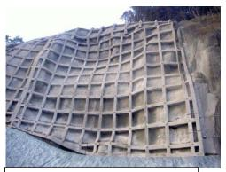
写真-4 黒崎沢の2斜面崩壊箇所の 本復旧工事完了状況
