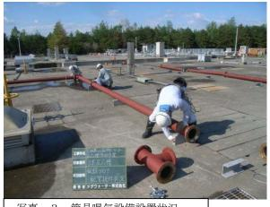
写真-3 簡易曝気設備設置状況
