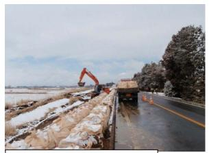
写真-1 迫川堤防応急対応の状況
