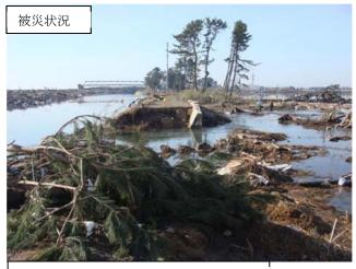
一級河川中貞山運河 名取市閖上地内 堤防被災状況(堤防破堤)
