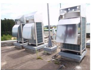
写真-4 化女沼ダム管理事務所 冷暖房設備の復旧状況
