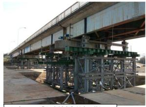
写真-2 豊里大橋応急対応の状況
