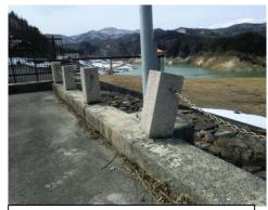
写真-1 荒砥沢ダム防護柵被災状況
