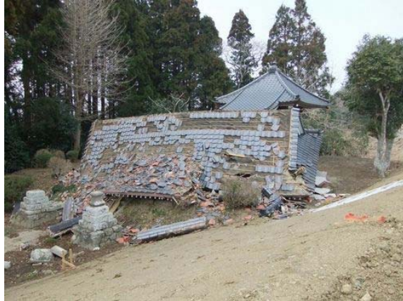
被災状況（左：鉄筋コンクリート造建築物2階部分の圧壊 右：木造建築物の倒壊）
