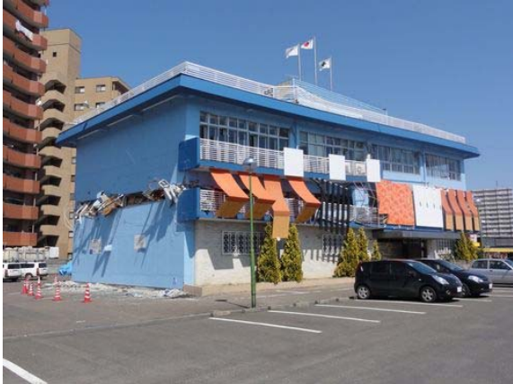
被災状況（左：鉄筋コンクリート造建築物2階部分の圧壊 右：木造建築物の倒壊）
