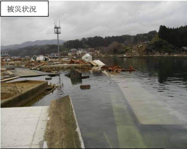
二級河川鹿折川 気仙沼市浜町2丁目地内 被災状況（堤防破堤）
