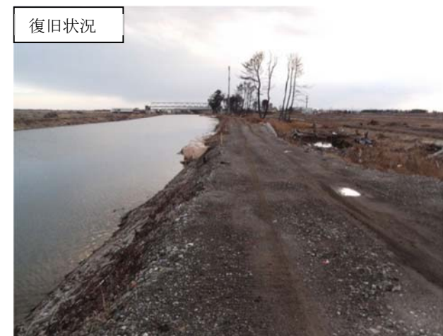
復旧状況 平成24年2月8日時点
