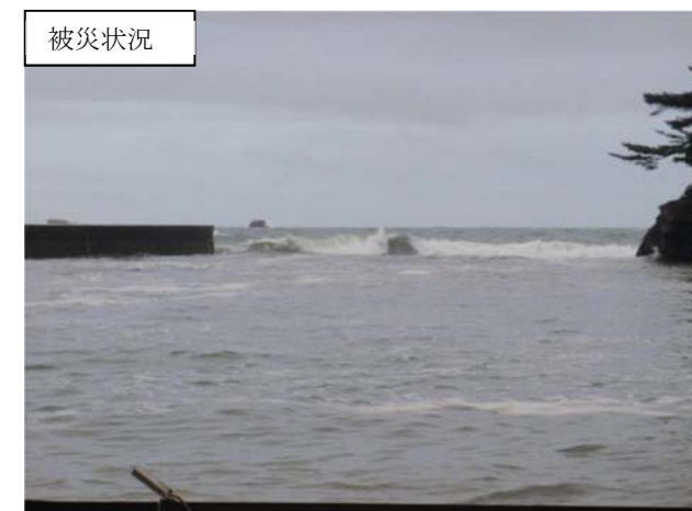
吉田・花浜地区 七ヶ浜町小浜地内 小浜防波堤被災状況（流失）
