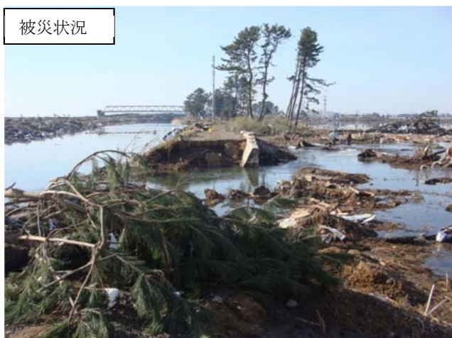
被災状況 一級河川中貞山運河 名取市關上地内 堤防被災状況（堤防破堤）
