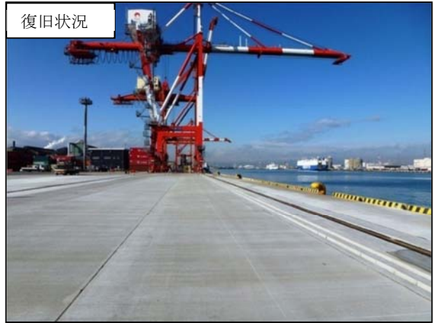
高砂コンテナターミナル コンテナ復旧状況
