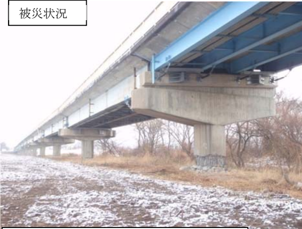
(主) 河南米山線 登米市豊里町川前地内 豊里大橋 橋脚破損
