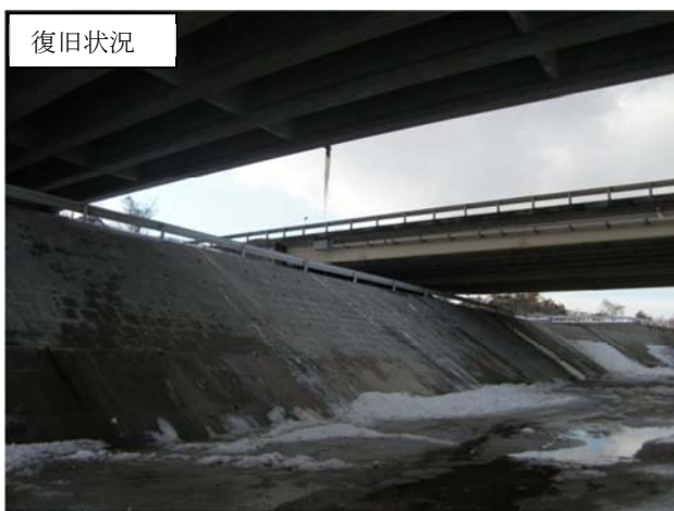
平成24年2月2日 災害復旧工完成
