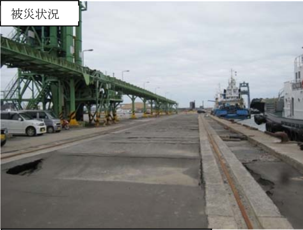
日和埠頭 石巻市潮見町地内 荷捌き地被災状況（陥没）
