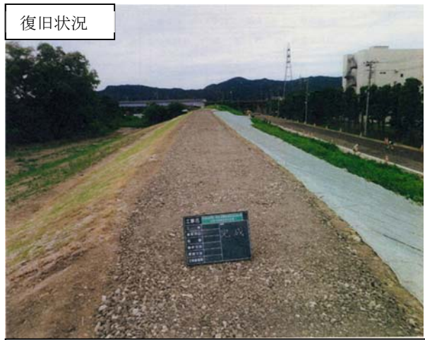
復旧状況 平成23年8月24日完了 堤防復旧（応急本工事）
