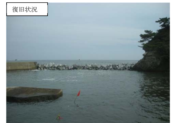
平成23年7月 応急仮工事完了
