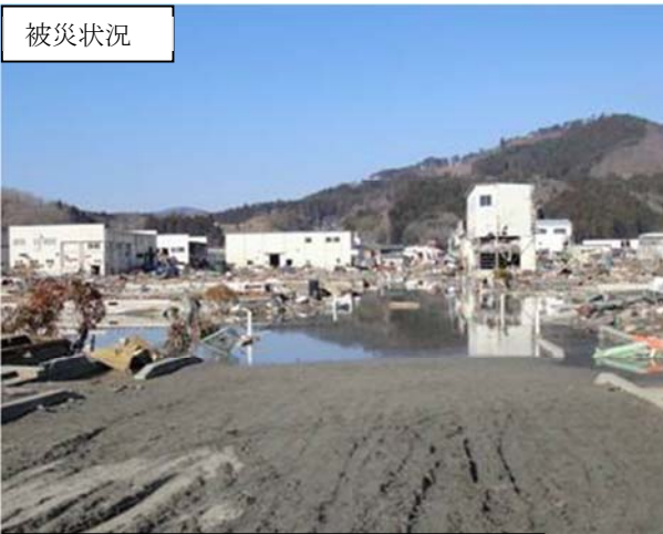
(主) 気仙沼唐桑線 気仙沼市波板地内 地震による路面の沈下
