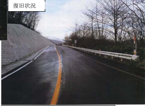
平成 23 年 11 月 30 日 本復旧完成
