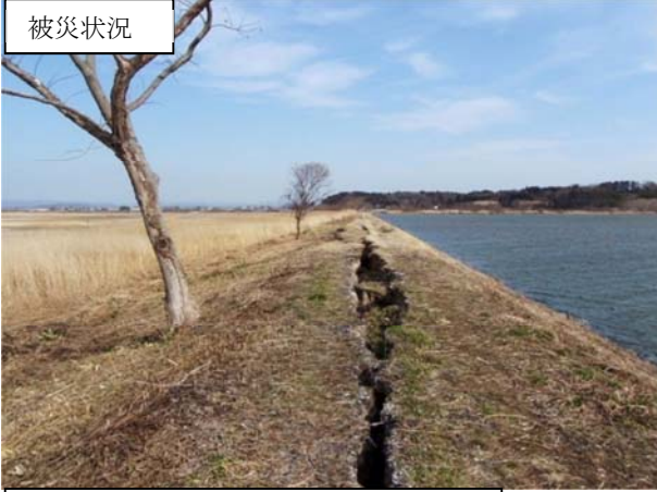
一級河川荒川 登米市迫町新田地内 堤防被災状況（堤防亀裂）
