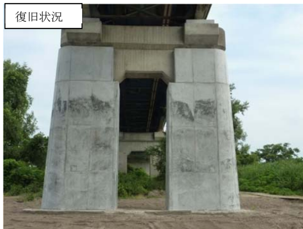
平成23年11月14日 災害復旧完了
