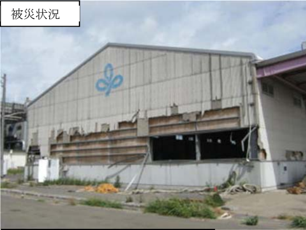
中島埠頭 上屋 津波による被災
