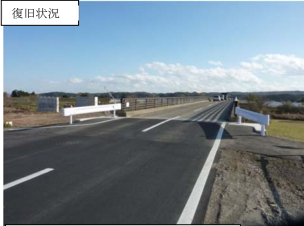
平成23年11月14日 災害復旧完了
