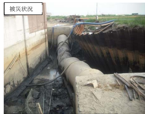
石巻東部浄化センター 放流管 管抜け出し被災状況
