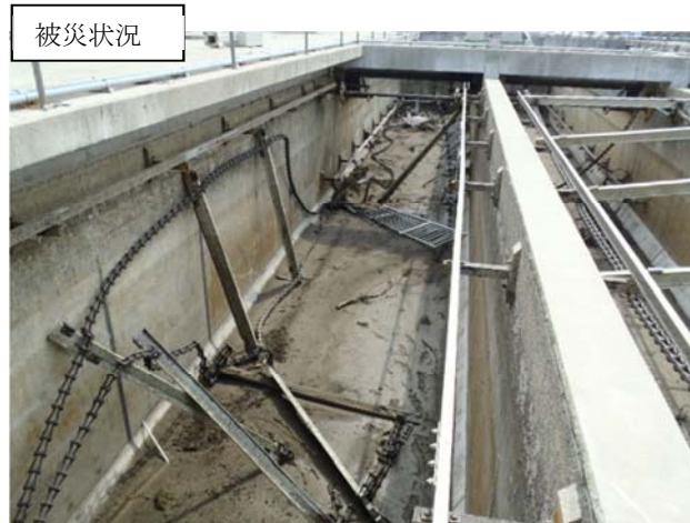
県南浄化センター 岩沼市下野郷地内 水処理施設損傷状況
