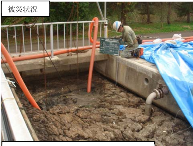
仙塩浄化センター 多賀城市大代地内 水処理施設汚泥堆積状況
