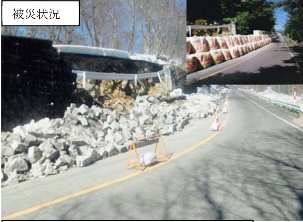
(主)白石上山線 蔵王町遠刈田温泉地内 ブロック積崩壊
