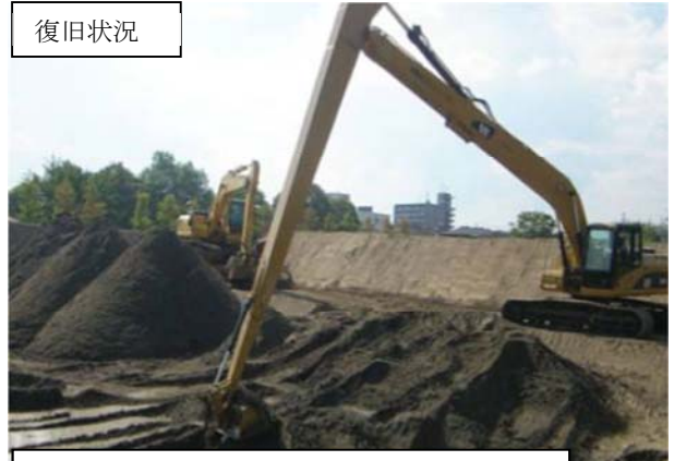
仙塩浄化センター 沈殿池汚泥撤去状況 (多賀城市大代地内)
