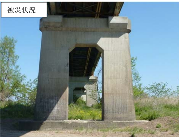
(主) 古川松山線志田橋 大崎市古川下中目～松山下伊場野地内 P6橋脚破損状況(コンクリート巻立補強)
