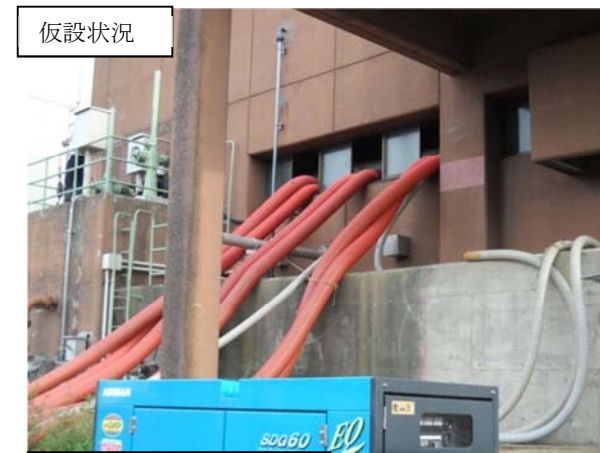
石巻東部浄化センター 仮設主ポンプ稼働状況
