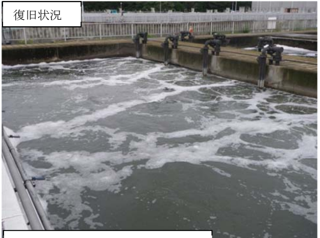
平成23年6月 仮設設備による簡易曝気開始
