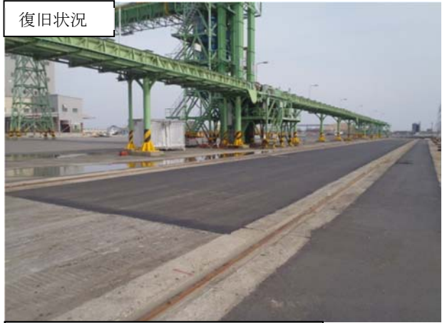
平成23年6月10日 仮舗装完成
