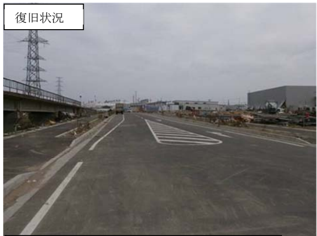
仙台港背後地 工業地区(港北工業幹線) 仙台市宮城野区港地内 復旧
