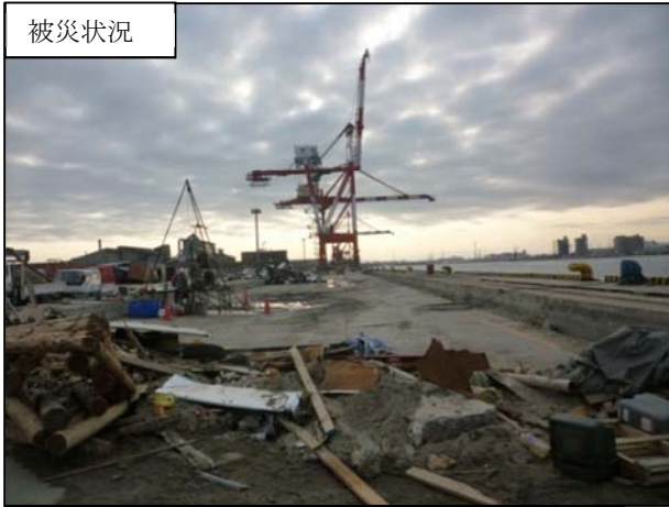
高砂コンテナターミナル 津波によるコンテナの散乱状況（仙台市宮城野区港地内）
