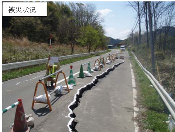
(一) 大河原高倉線 角田市毛萱字宮ノ下地内 路面陥没
