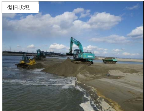
復旧状況 平成23年2月6日 河口掘削作業状況
