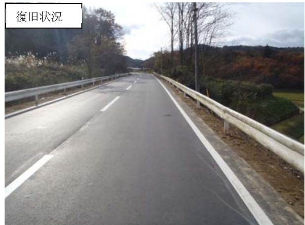
平成 23 年 11 月 25 日 復旧完了
