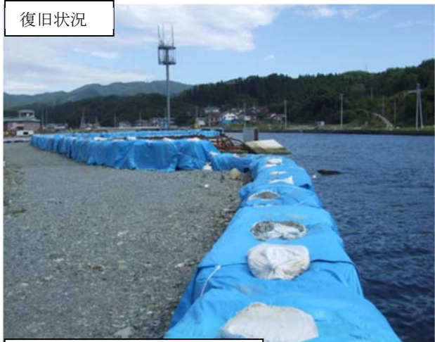
応急復旧（大型土のう）
