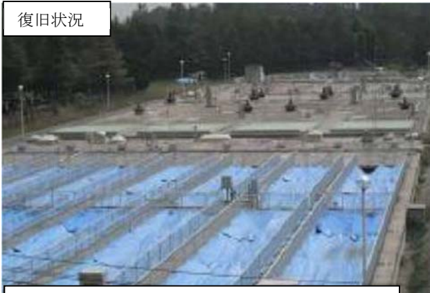
仙塩浄化センター シート覆工による臭気対策 (多賀城市大代地内)
