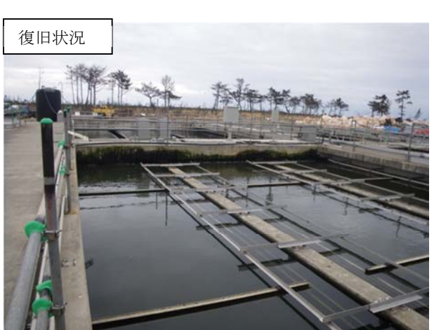
平成23年7月 仮復旧状況
