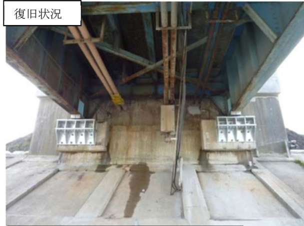
平成23年11月14日 災害復旧完了
