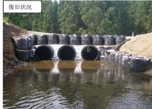
平成 23 年 5 月 31 日 応急工事完了
