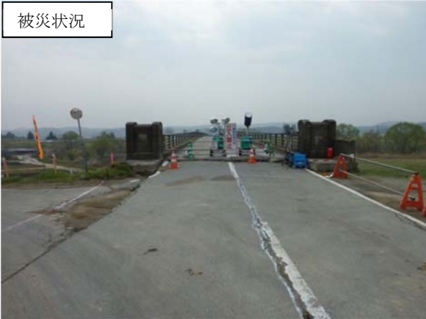
(主) 古川松山線志田橋 大崎市古川下中目～松山下伊場野地内 A1側すり付け部破損状況
