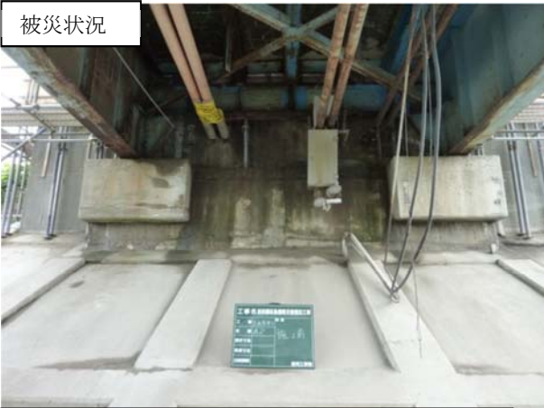
(主) 古川松山線志田橋 大崎市古川下中目～松山下伊場野地内 A2橋台支承部破損状況
