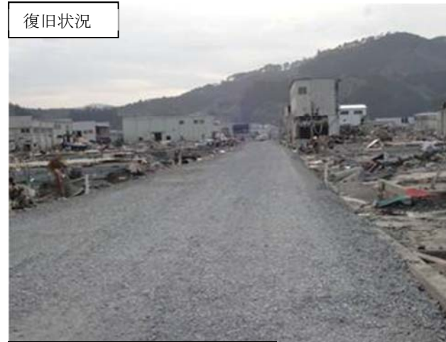
路面かさ上げによる応急復旧
