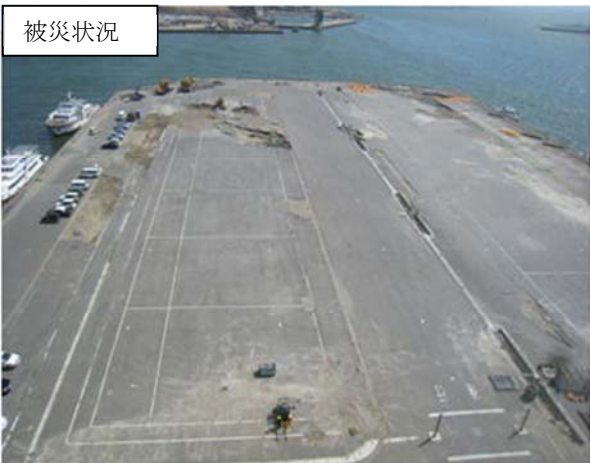
日和埠頭 上屋 津波による被災
