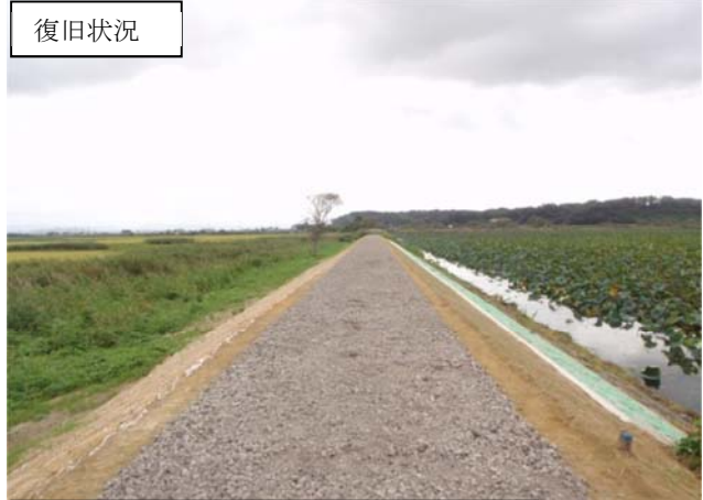
平成23年9月17日撮影 堤防復旧
