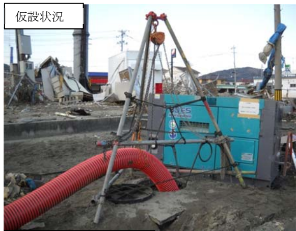
石巻第6ポンプ場 仮設ポンプ稼働状況
