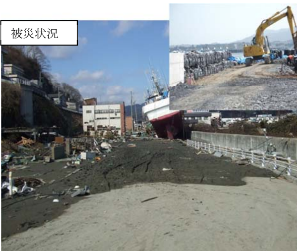
(主) 気仙沼唐桑線 気仙沼市魚浜町地内 被災状況 (支障船舶及び地盤沈下)
