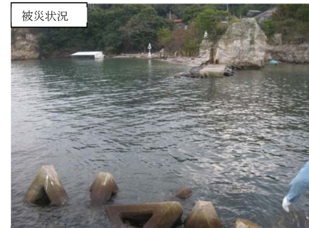
浦戸桂島地区 塩釜市浦戸石浜地内 石浜防波堤被災状況（流失）
