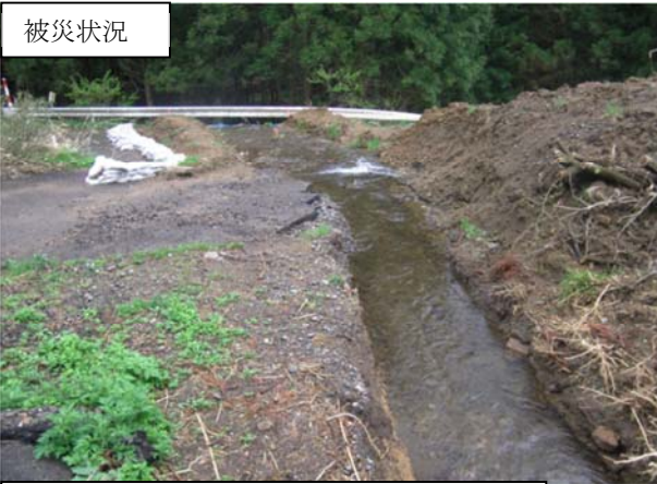
(国) 4 5 7 号 白石市福岡深谷地内 路面流出
