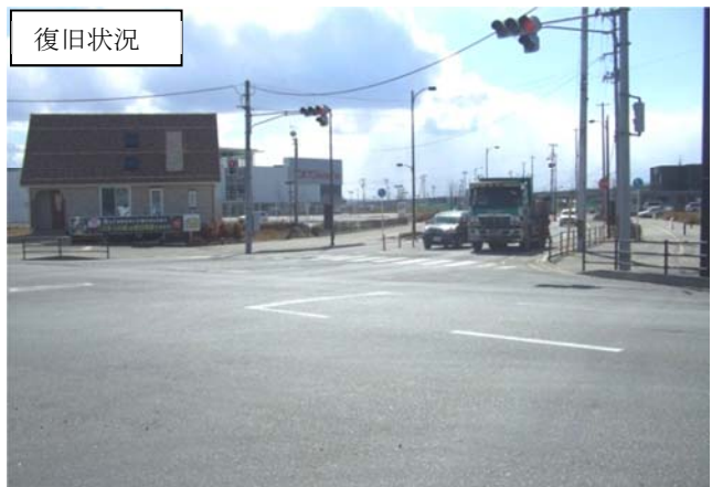
平成23年6月 応急本工事完成
