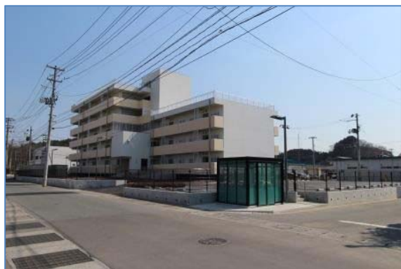
東松島市鳴瀬給食センター跡地地区（完成）
