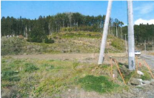
被災地域農業復興総合支援事業_ネギ集荷調製施設 着工前 完成
