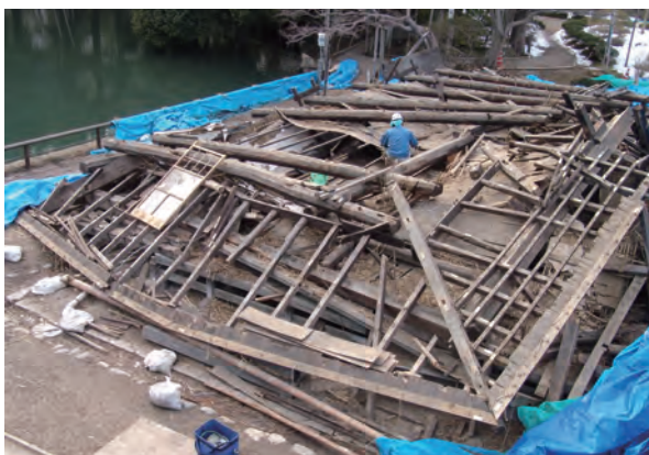
写真5-11 屋根の解体作業
