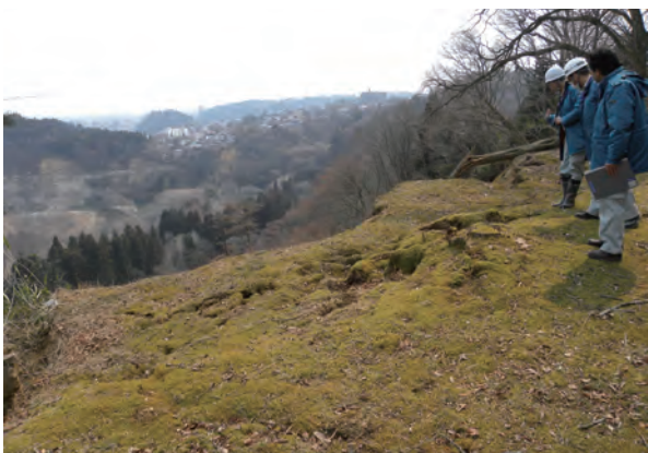
写真3-24 史跡仙台城跡本丸地割れ (1-29)
