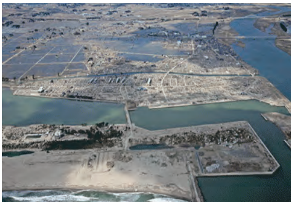
写真1-3 名取市津波被災状況
