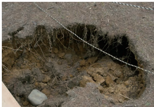
写真2-9 史跡雷神山古墳後円部陥没
