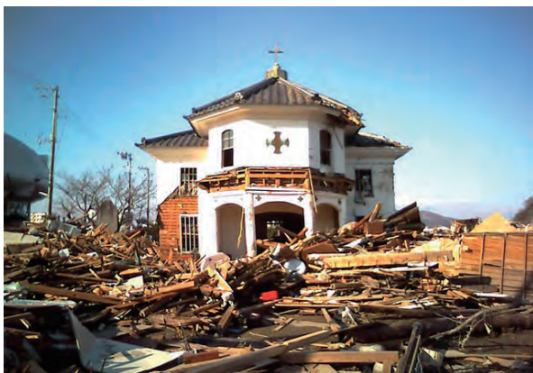
写真5-14 瓦礫が押し寄せた教会堂
