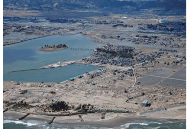
写真1-2 亘理町津波被災状況
