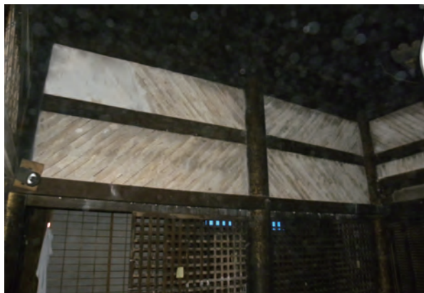
写真3-11 陸奥国分寺薬師堂 (1-6)
