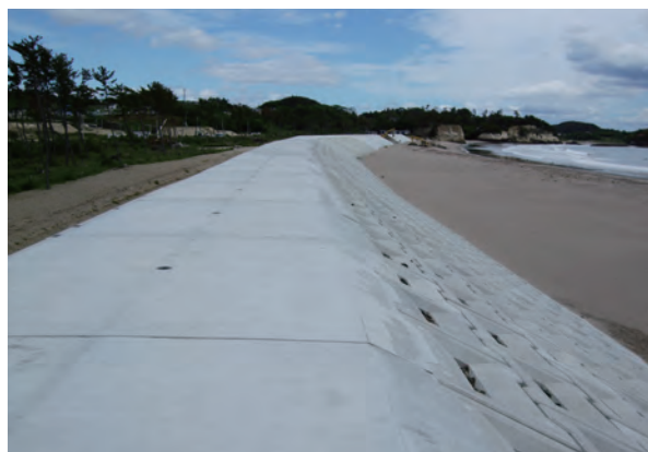
写真7-6 七ヶ浜町菖蒲田浜の防潮堤
