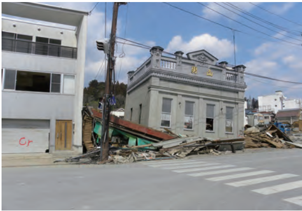
写真5-17 1・2階部分が倒壊した男山本店
