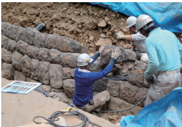
写真5-8 石垣の積み直し作業
