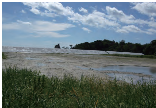
写真7-4 塩竈市野々島の防潮堤
