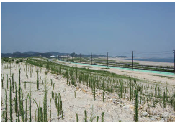
写真7-5 東松島市野蒜海岸の防災林盛土
