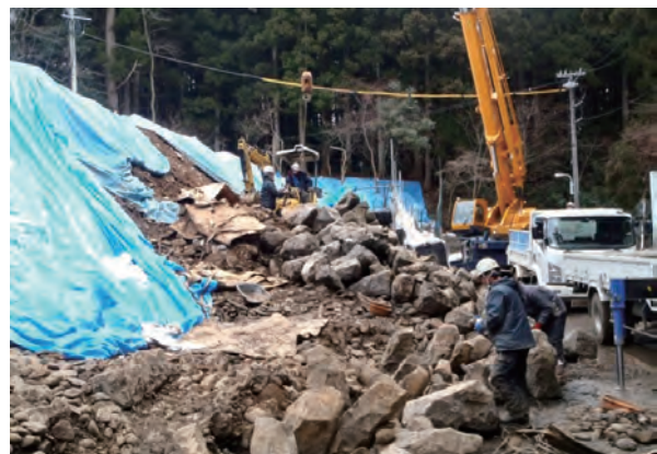
写真5-7 崩落石垣の石材搬出
