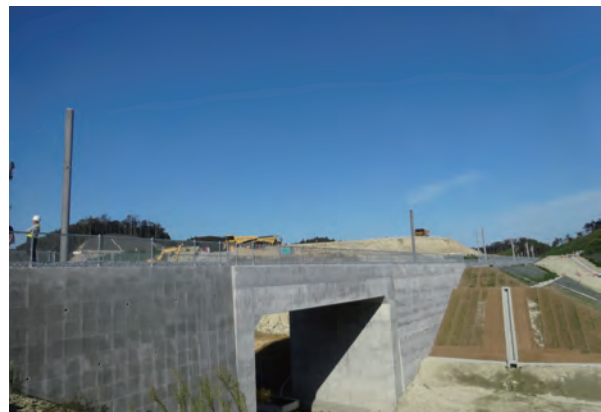
写真7-8 東松島市JR仙石線建設
