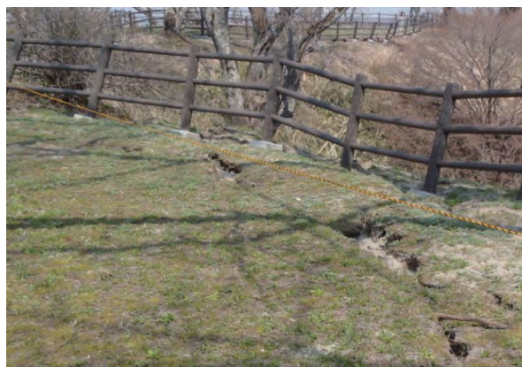
写真3-25 史跡岩切城跡平場地割れ (1-45)
