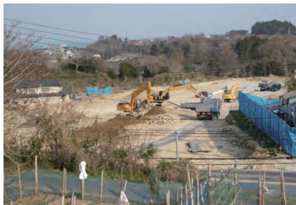
写真7-3 七ヶ浜町代ヶ崎浜地区高台移転地
