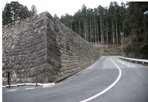
写真5-9 積み直し完了後の石垣
