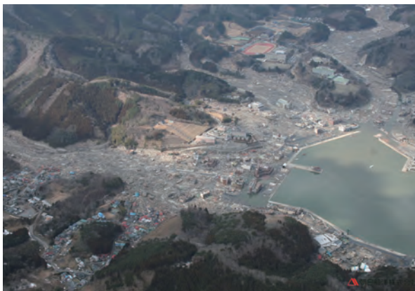
写真2-11 女川町津波被災状況
