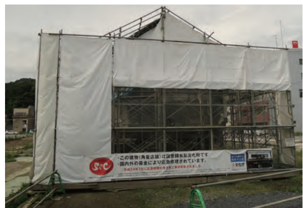
写真6-25 角星店舗の修理（気仙沼市）
