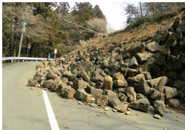
写真3-23 史跡仙台城跡石垣崩落状況 (1-29)
