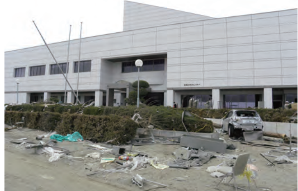
写真3-44 津波浸水後の石巻文化センター
