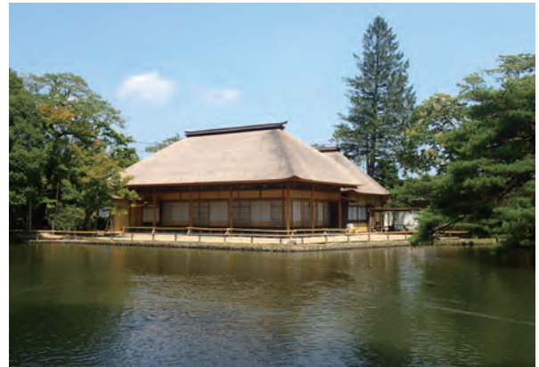
写真5-13 復旧した旧有備館及び庭園
