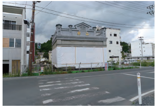
写真5-18 シートで覆われた状況
