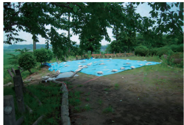
写真3-43 大和町八谷館跡平場地割れ
