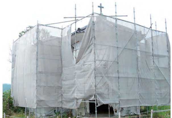
写真5-16 教会堂修復作業
