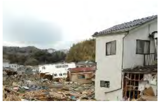
写真3-30 宮戸島の被災状況
