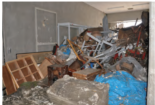
写真3-45 開口部から押し寄せた瓦礫
