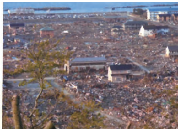
写真1-4 石巻市津波被災状況 文献2より
