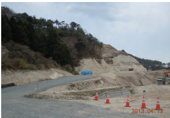
写真7-7 東松島市野蒜の道路建設
