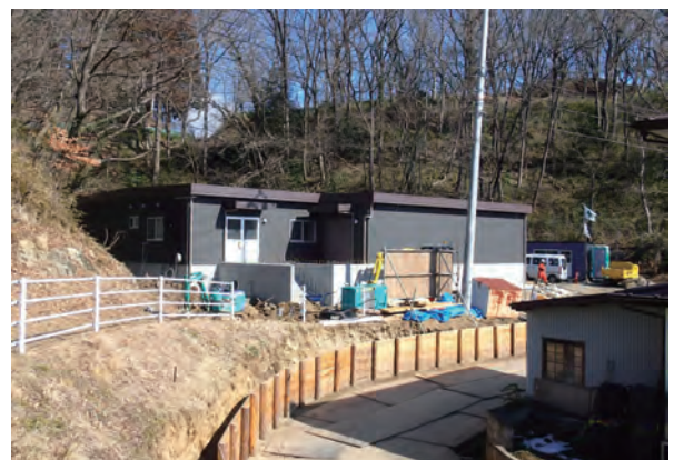
写真6-12 村田町仮設収蔵施設
