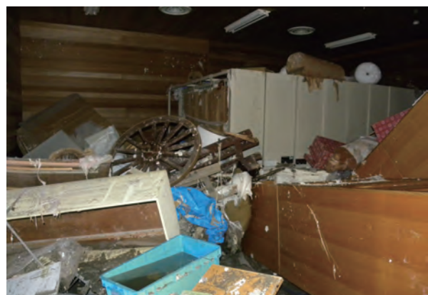
写真3-46 紙パルプ等の流入による被害状況
