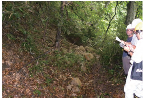
写真3-38 青葉山の被災状況 (1-50)
