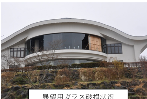
展望用ガラス破損状況
