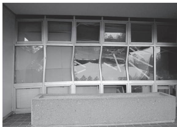
1階 事務室外側窓
