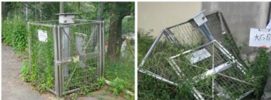
被害がなかった泊浜MP (H23. 9.13 撮影) 全壊した大石原MP (H23. 9.13 撮影)
