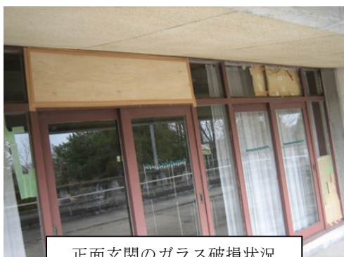
正面玄関のガラス破損状況
