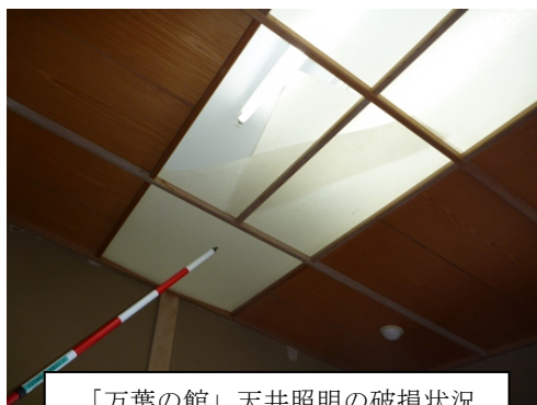
「万葉の館」天井照明の破損状況
