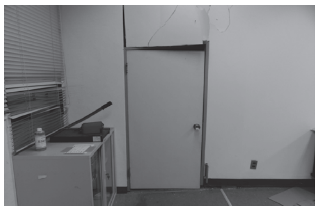
1階所長室 沈下によるドアの歪み
