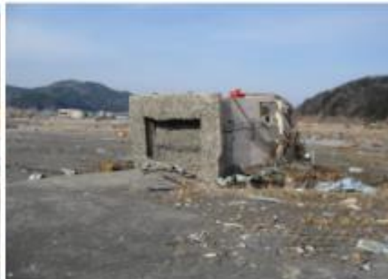
流失した谷川局(H23. 4.7 撮影)
