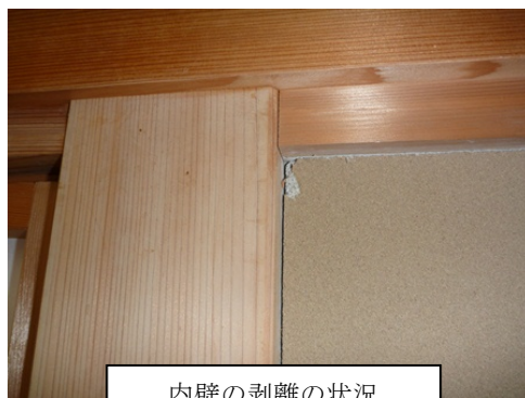
内壁の剥離の状況
