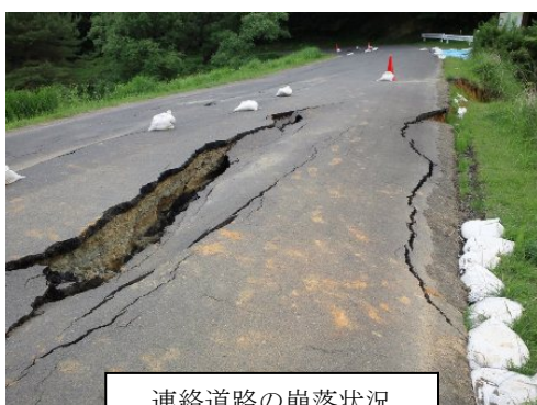
連絡道路の崩落状況
