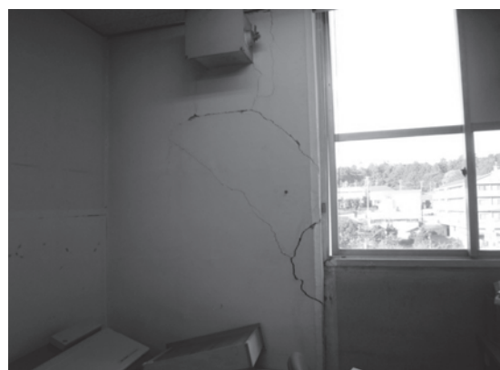
4階分析室 柱のひび割れ
