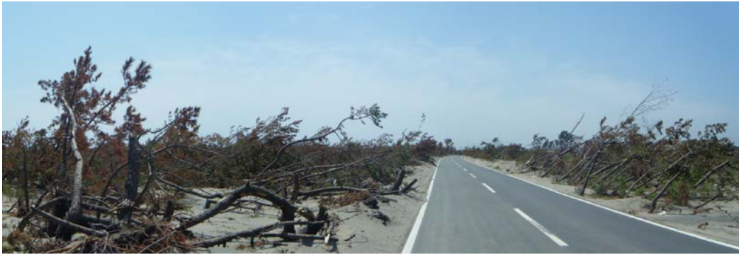
倒壊したクロマツ海岸林（岩沼市）
