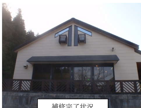
補修完了状況
