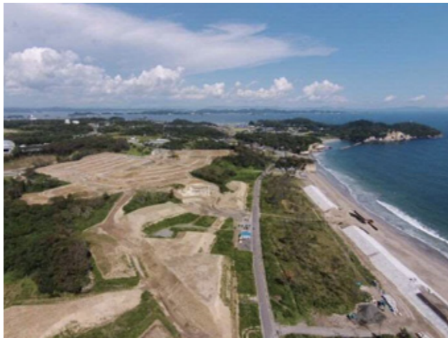
写真:高台移転の様子(七ヶ浜町)
