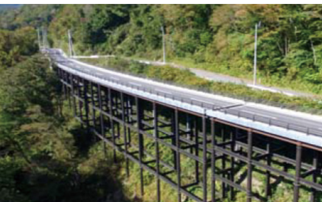
写真:通年通行化した国道347号線
