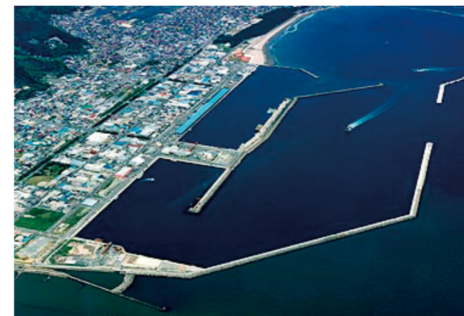
写真:石巻漁港の復旧状況(石巻市)
