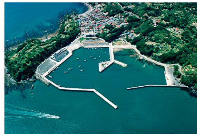
写真:仁斗田漁港の復旧状況(石巻市)
