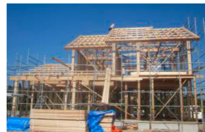
写真:優良みやぎ材での新築住宅支援
