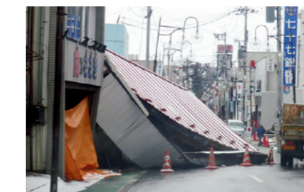
登米市(倒壊した住宅)
