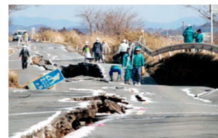
青森市(大きく波打った道路)
