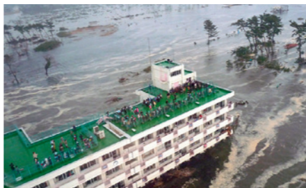
仙台市(孤立する荒浜小学校)
