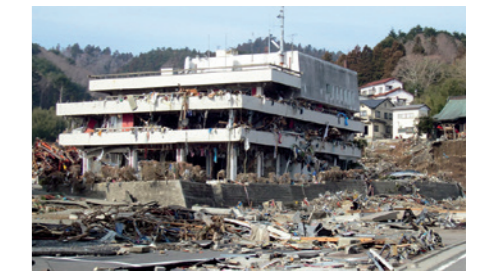
女川町(3階まで浸水した役場庁舎)
