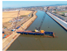
写真：定川での橋脚工事のための仮橋設置(東松島市)
