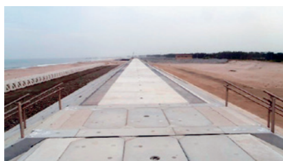
写真：荒浜の防潮堤の様子(亶理町)
