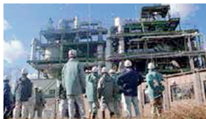
写真：仙塩浄化センター 汚泥焼却施設の復旧が完了
