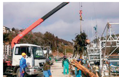
写真:漁船により回収された瓦礫の陸揚げ作業
