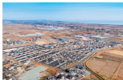
写真：つばめの杜地区(山元町)
