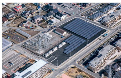
写真：石巻蛇田太陽光発電所(石巻市)
