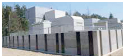
写真：仙塩浄化センター 自家発電施設の耐水壁設置完了
