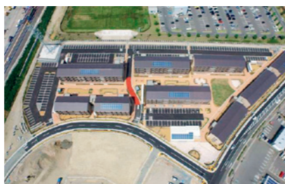
写真：災害公営住宅のソーラー発電(石巻市)
