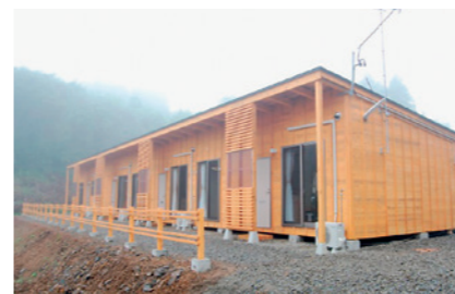
写真:地域木材を使用した仮設住宅(南三陸町)
