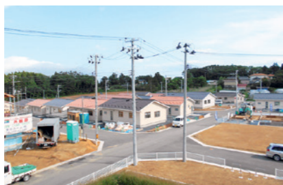
写真：防災集団移転地区(気仙沼市)
