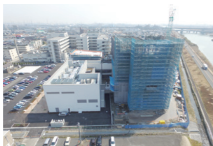
写真: 東北医科薬科大学の平成27年度末時点建設状況
