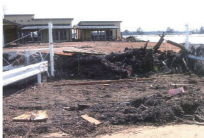
写真:被災した障害福祉施設
