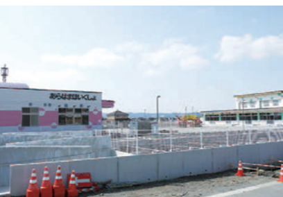
写真:再建工事が進む保育所と児童館(巨理町)
