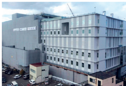
写真: 石巻市立病院(石巻市)
