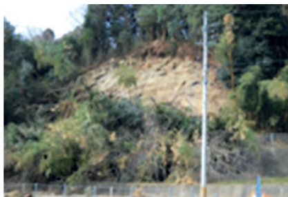
写真:被害状況(平成23年3月 県道閉塞(東松島市))
