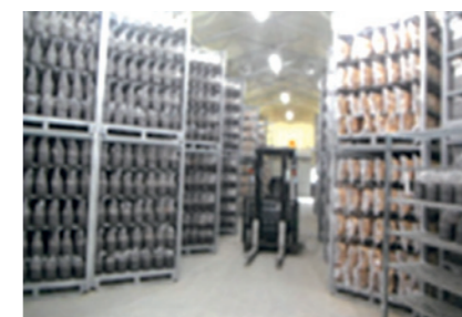
写真:津波で被災した特用林産施設の復旧
