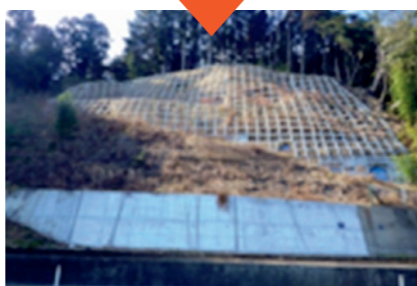
写真:完成後(平成26年度 法粋工・土工)
