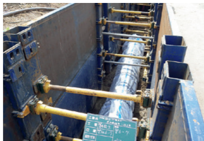
写真：高区・低区送水連絡管整備（平成26年度）
