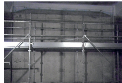
写真：麓山第一調整池耐震補強工事
