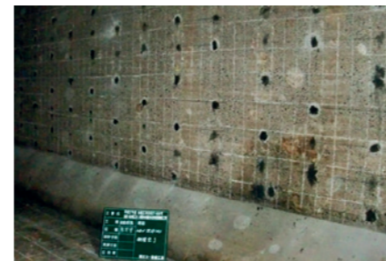
写真：熊野堂沈砂池耐震補強工事
