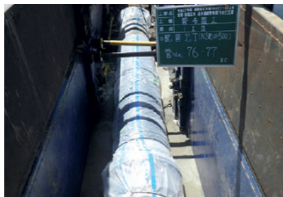
写真：高区・低区送水連絡管整備（平成27年度）
