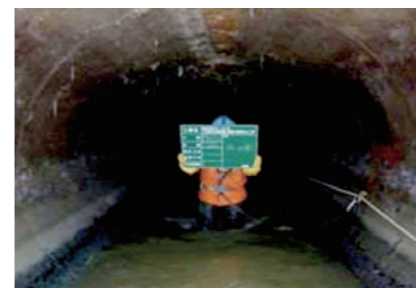
写真:下水長寿命化工事の様子(多賀城市)
