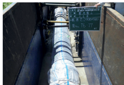
写真:高区・低区送水連絡管整備
