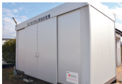
写真:志津川高校の備蓄倉庫
