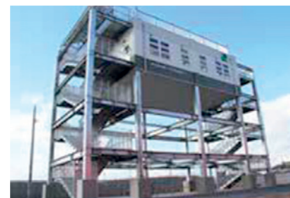
写真:津波避難タワー
