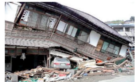
写真:倒壊した家屋(気仙沼市)
