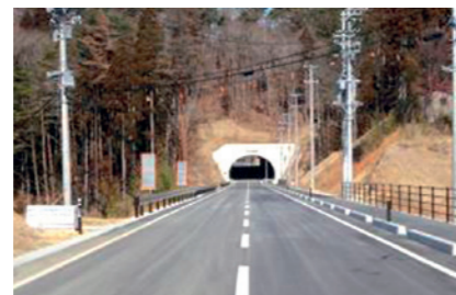
写真:大島架橋乙女2号トンネル(気仙沼市)
