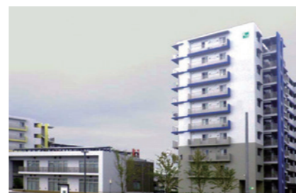
写真:南郷住宅(災害公営住宅)(気仙沼市)
