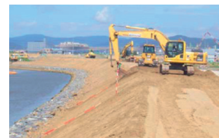
写真:北上川運河災害復旧工事(東松島市)
