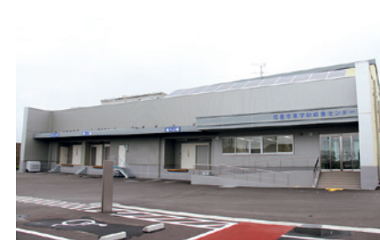
写真:石巻市東学校給食センター(石巻市)
