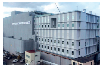
写真:建設中の石巻市立病院(石巻市)
