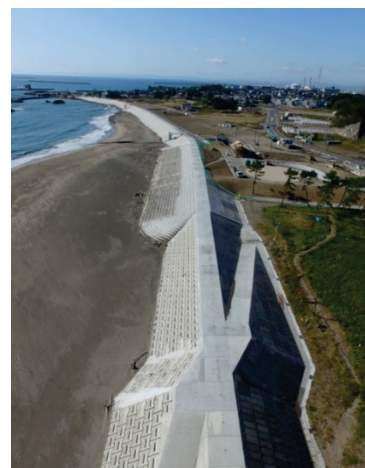
■写真 4-2-13：「粘り強い」構造で施工した防潮堤 (七ヶ浜町_菖蒲田海岸)
