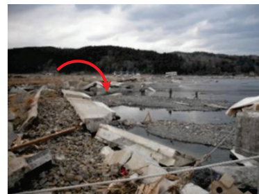
■写真 4-2-12：引き波で堤防が海側に倒壊
