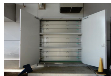
■ 写真 4-3-14：自家発電室入口に防水壁設置
