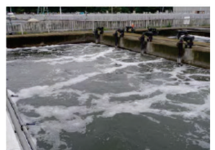
■写真 4-3-20：簡易曝気処理開始
