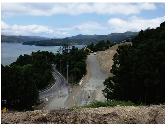
■写真 4-3-11：石巻鮎川線 風越2工区
