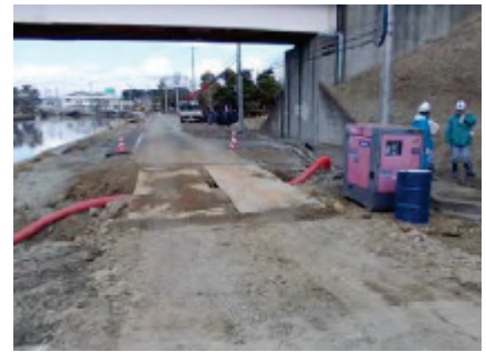
■写真 4-3-17：仮復旧完了
