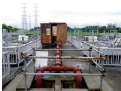
■写真 4-3-19：仮設フロア設置完了
