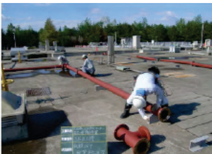
■写真 4-3-18：仮設フロア設置状況
