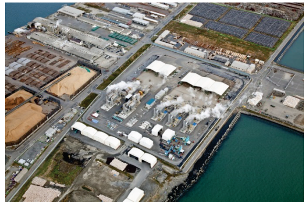
■写真 4-3-11：仙台塩釜港石巻港区雲雀野地区
