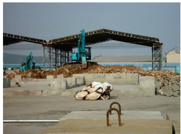
■写真 4-3-12：仙台塩釜港石巻港区雲雀野地区
