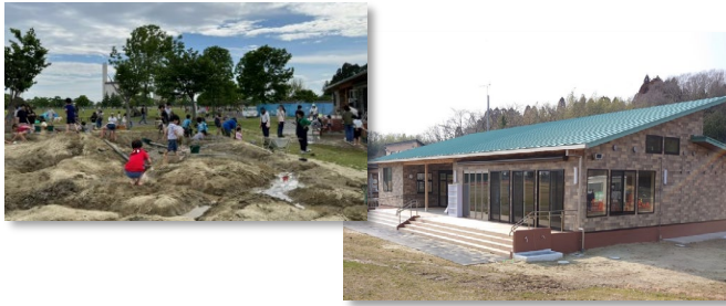
図5 加瀬沼公園（プレイパークと管理棟） 〔2024(令和6)年3月完成〕
