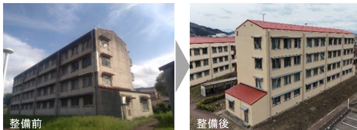
図7 県営住宅の長寿命化（外壁等改修工事） 〔2023(令和5)年12月完成〕
