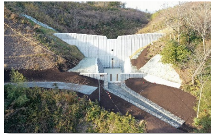
図2 山崎沢砂防堰堤 〔2023(令和5)年12月完成〕
