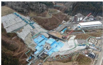
図1 川内沢ダム建設状況 〔2025(令和7)年3月時点〕
