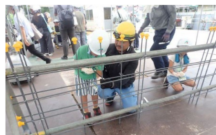
図10 小学生と保護者の建設現場見学会 （仙台家畜保健衛生所改築工事）
