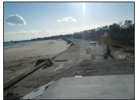
菖蒲田海岸 2工区の状況(七ヶ浜町)
