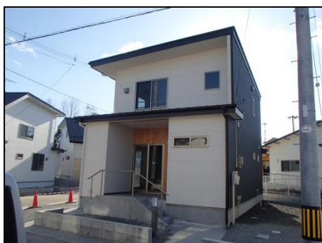
伊保石地区（一期） 完成状況（塩竈市）
