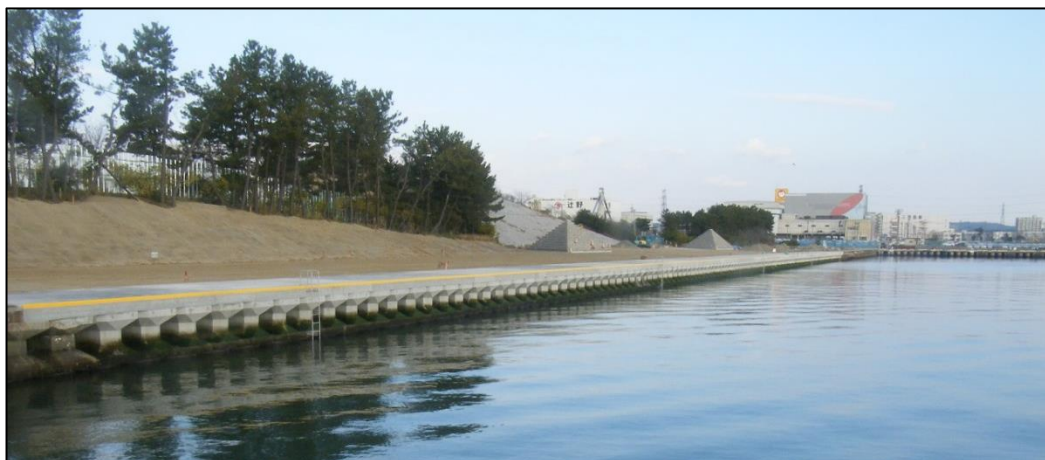
仙台塩釜港（仙台港区）雷神護岸 直立消波ブロック据付完了状況（仙台市）
