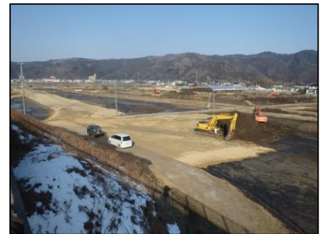
新渡波西地区 造成状況（石巻市）
