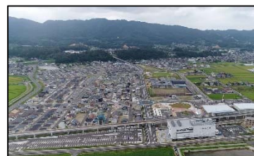
新山下駅周辺地区（山元町）
