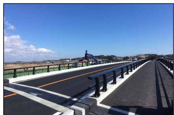
大和松島線（西川橋） (大和町)
