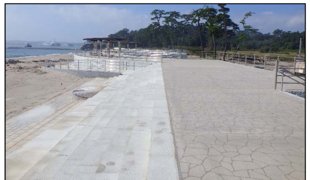
桂島前浜護岸 (塩竈市)
