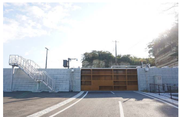
花淵浜吉田浜地区 吉田花淵防潮堤 (七ヶ浜町)
