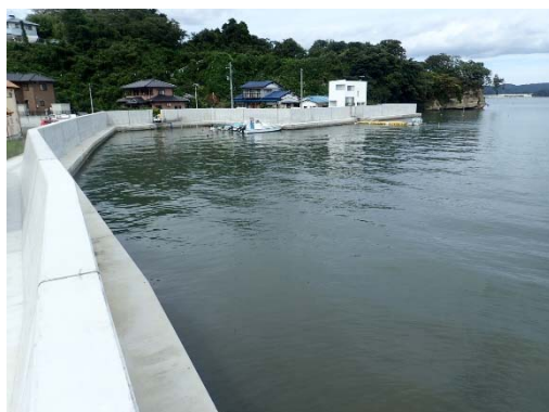
東宮浜代ヶ崎浜地区 小友浜護岸 (七ヶ浜町)
