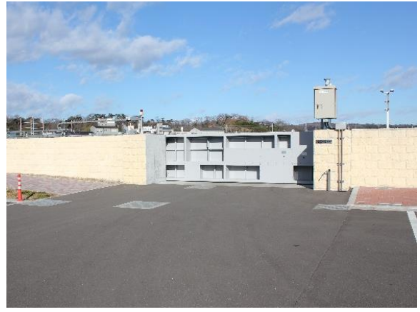
港町防潮堤（塩竈市）
