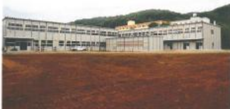
宮城県農業高等学校仮設校舎
