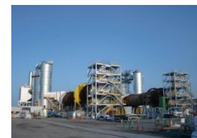
焼却炉の設置状況 【石巻ブロック】
