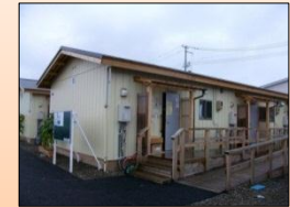
プレハブ仮設住宅(名取市)
