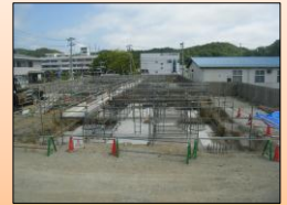
建設中の災害公営住宅 (東松島市)
