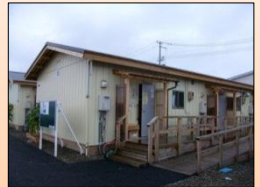
プレハブ仮設住宅(名取市)
