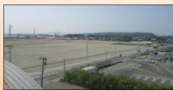
<土地区画整理事業> 新蛇田地区盛土工事状況(石巻市)
