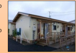
プレハブ仮設住宅(名取市)
