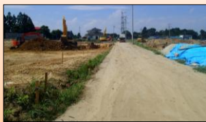
＜防災集団移転促進事業＞ 松ヶ浜西原地区 造成工事状況(七ヶ浜町)
