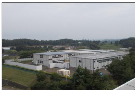
仮設校舎 (宮城県農業高等学校)
