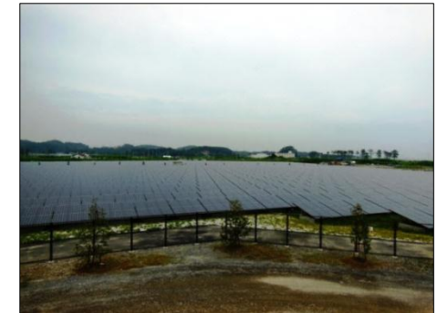
大規模太陽光発電所(メガソーラー) (東松島市)
