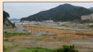
＜土地区画整理事業＞ 中心部地区造成工事状況(女川町)
