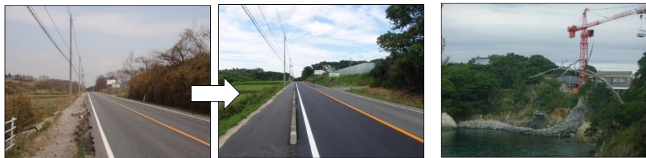
主要地方道塩釜吉岡線 復旧状況 (大和町) 網地地区海岸工事状況 (石巻市)
