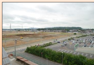
新蛇田地区造成工事状況 (石巻市)
