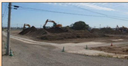
牛網地区造成工事状況 (東松島市)
