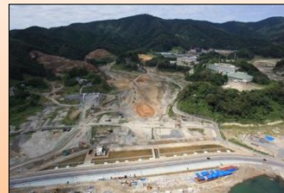
中心部地区造成工事状況 (女川町)
